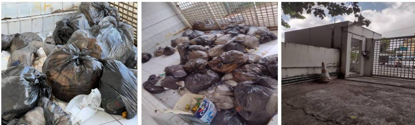
Por meio de visita *in loco* verificou-se a presença de sacos rasgados e amontoados diretamente no chão, além de resíduos expostos e uma péssima condição de higiene da sala acompanhada de um intenso e desagradável odor. As constatações evidenciam falhas no acondicionamento e inadequação da infraestrutura da sala para armazenamento.
