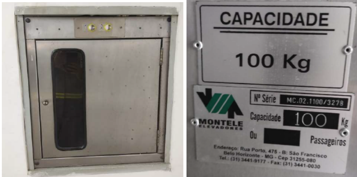
Foto 01 e 02 - Monta carga do almoxarifado (Bloco D). Marca Montele, capacidade 100 Kg
