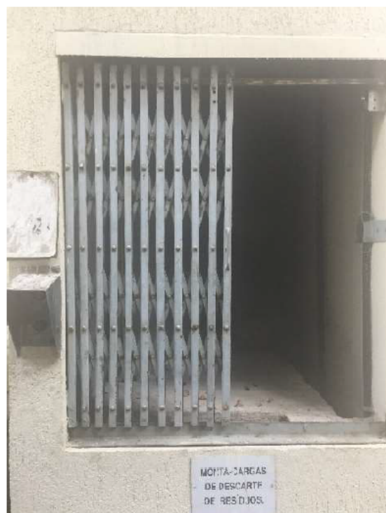
Foto 04 - Monta carga do biotério (2 iguais), capacidade 100 Kg
