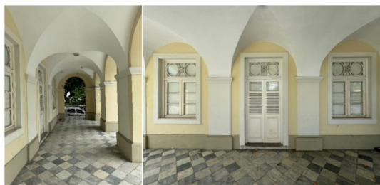
Figura 39: Pórtico. Fonte: Pedro Valadares Arquitetura, 2024.
