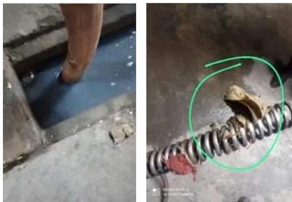
6. AÇÃO: Desobstrução de tubulação de água pluvial e esgoto no anexo do Entroncamento.
